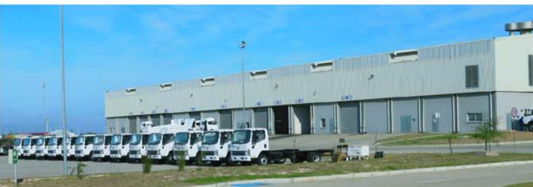
PEI厂 PE Plant
